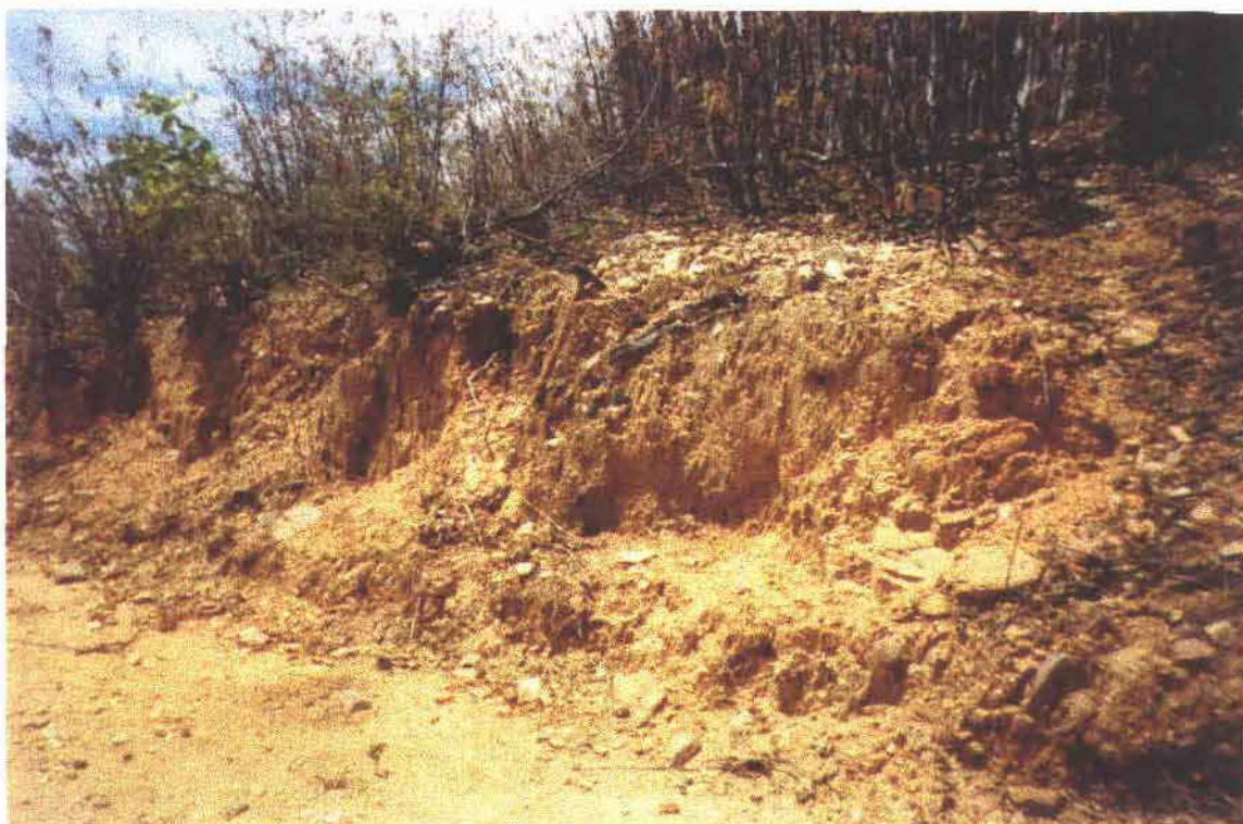
FOTO 03: Vista a montante da Barragem Chile, onde se observa o ARGISSOLO VERMELHO AMARELO, raso, abrupto, bastante representativo da área.
